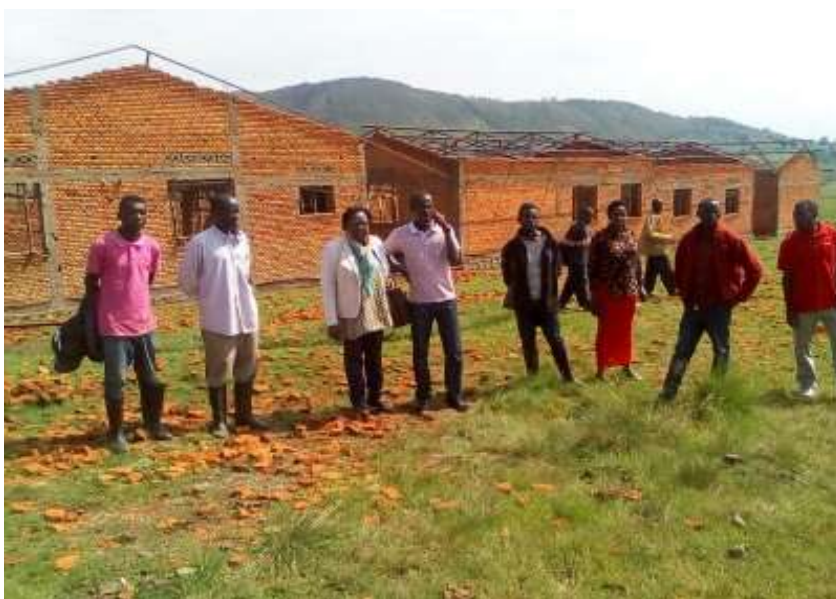
Installation de la charpente. Photo du 24/01/2019
